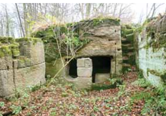
Obr. 7. Ve vstupu do podzemní části mlýna na hrázi Dolanského rybníka je vidět vybrání pro hřídel mlýnského kola o průměru 60 centimetrů.
